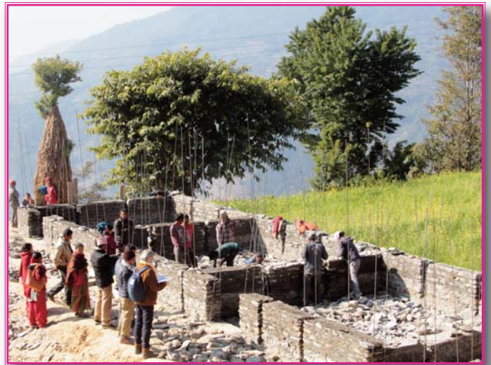
Fra byggingen av en av de nye skolene i Dolakha
