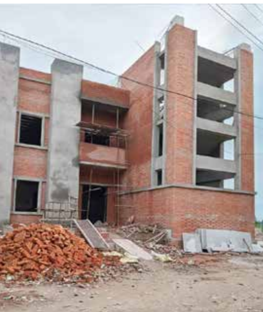
På byggeplassen på Kanti, mai 2020.
